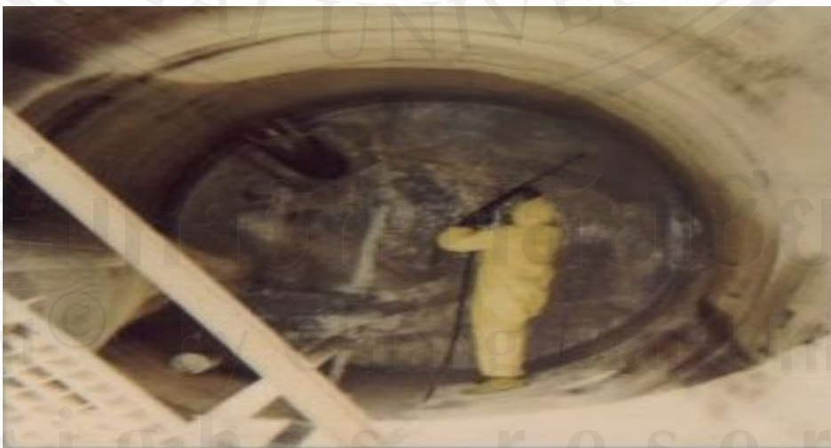
ภาพที่ 2.13 แสดงการพ่นทรายด้านในของถัง
