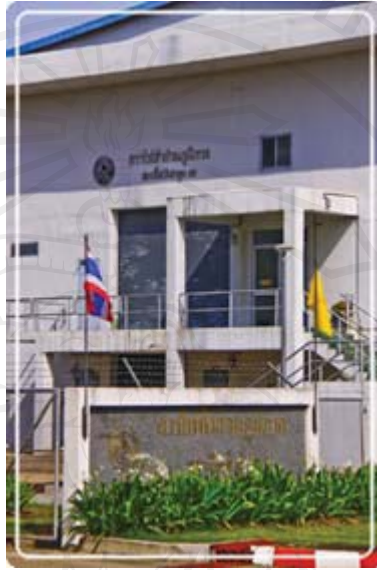
ภาพที่ 2.2 สถานีไฟฟ้าย่อยของการไฟฟ้าส่วนภูมิภาคภายในเขตสวนอุตสาหกรรมเครือสหพัฒน์ ลำพูน
