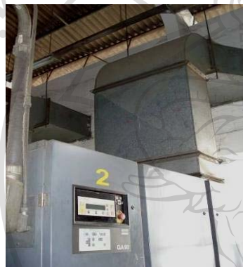
รูปผนวกที่ 10 เครื่องอัดอากาศแบบสกรู
