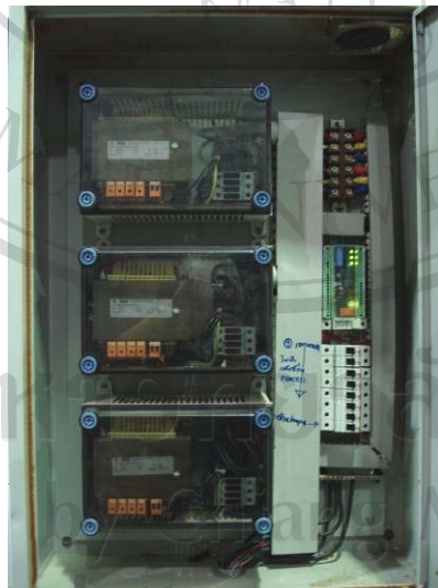
รูปผนวกที่ 9 เครื่องอิเล็กทรอนิกส์ควบคุมแรงดันไฟฟ้า
