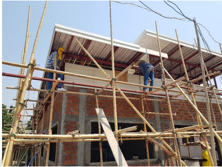
ภาพที่ 4.16 งานติดตั้งผนังไม้ฝา
