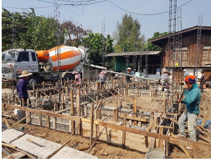
ภาพที่ 4.8 งานเทคอนกรีตคาน
