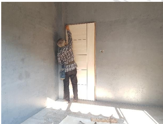
ภาพที่ 4.21 งานติดตั้งประตู
