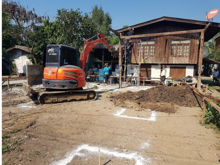
ภาพที่ 4.2 วางผังอาคารเพื่อกำหนดตำแหน่งเสา
