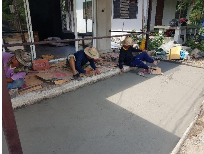
ภาพที่ 4.25 งานติดตั้งติดตั้งราวกันตก และเทพื้นฟุตบาท
