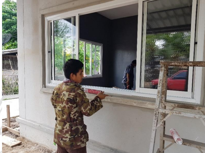
ภาพที่ 4.18 งานติดตั้งบัวสำเร็จรูป
