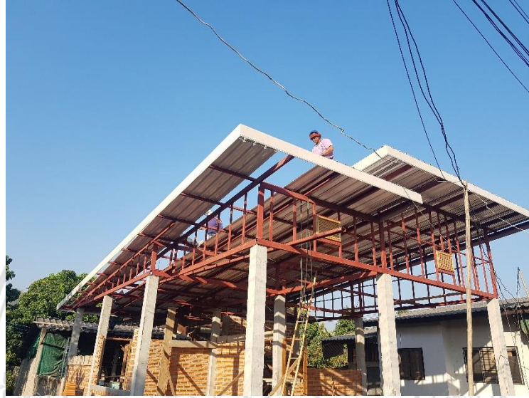
ภาพที่ 4.12 งานมุงแผ่นหลังคา
