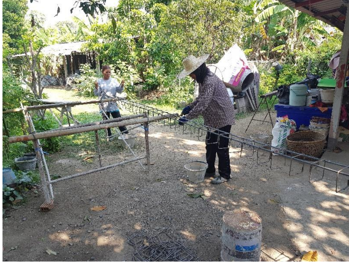
ภาพที่ 4.4 งานมัดเหล็กฐานรากและเสา
