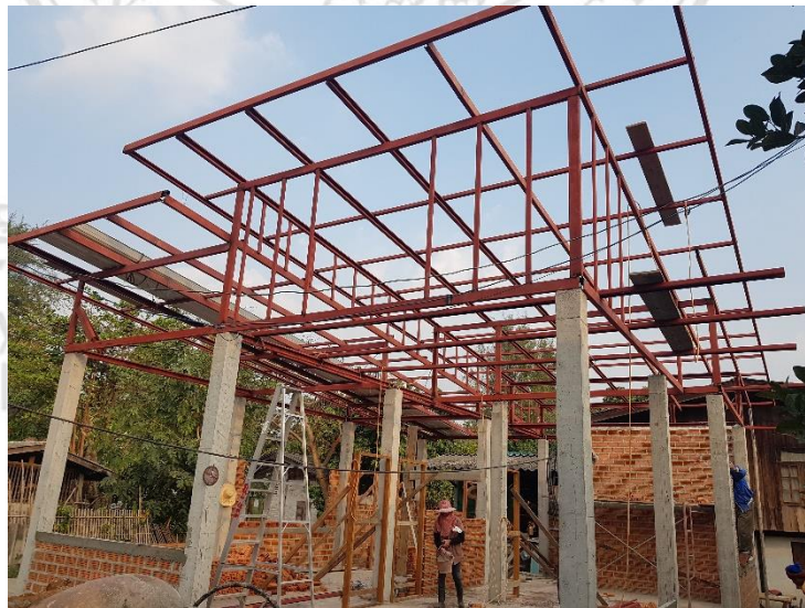
ภาพที่ 4.11 งานโครงหลังคาเหล็ก
