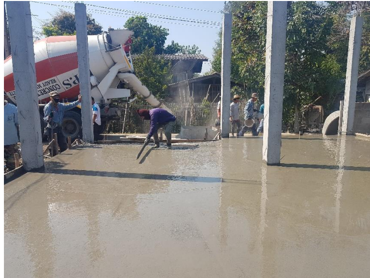
ภาพที่ 4.10 งานวางแผ่นพื้นและเท Topping
