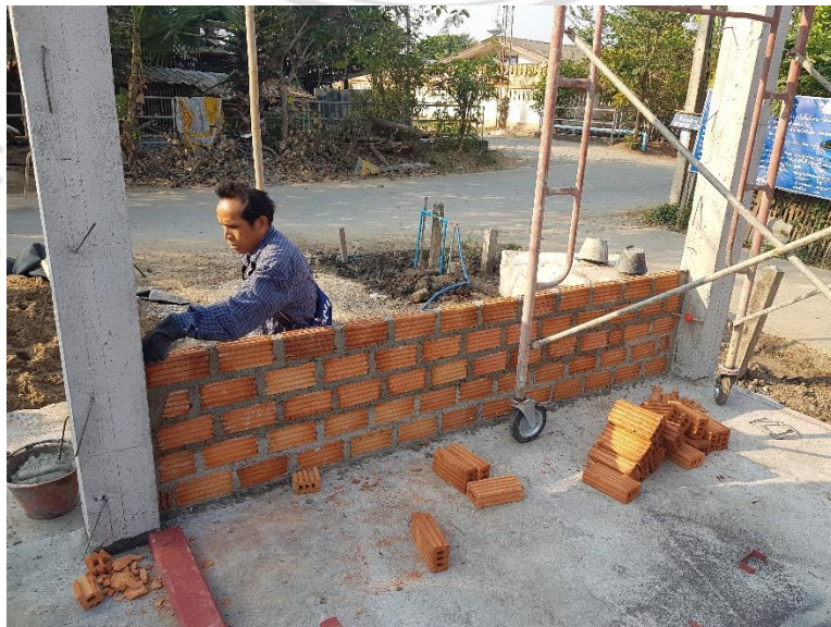
ภาพที่ 4.13 งานก่อผนัง
