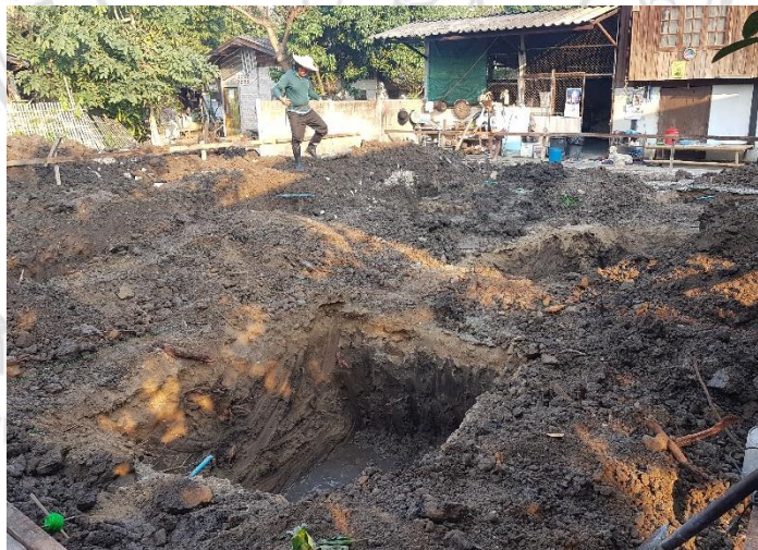
ภาพที่ 4.3 งานขุดหลุมฐานราก
