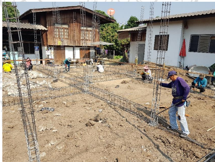
ภาพที่ 4.7 งานมัดเหล็กคาน
