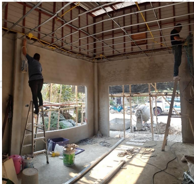
ภาพที่ 4.17 งานติดตั้งฝ้าเพดานและติดตั้งระบบไฟฟ้า
