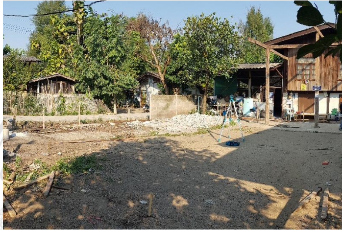
ภาพที่ 4.1 การเตรียมพื้นที่ก่อนเริ่มงานฐานราก
