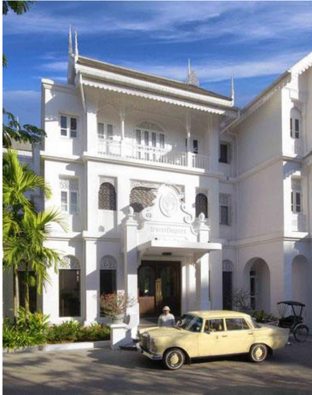
ภาพ 4.10 ด้านหน้าของเรือนขนมปังขิง ซึ่งจะเป็นส่วนทางเข้าโรงแรม โดยมีห้องโถงและแผนกต้อนรับอยู่ในส่วนนี้
