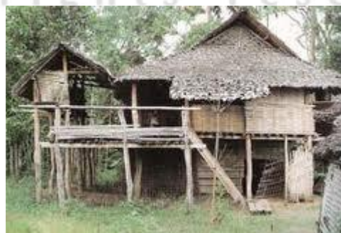
ภาพ 4.4 เรือนไม้บัว หรือเรือนเครื่องผูกใต้ถุนสูง
