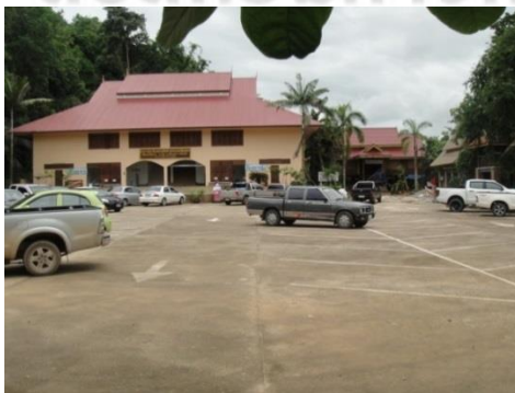
ภาพที่ 5.44 บริเวณลานจอดรถ
