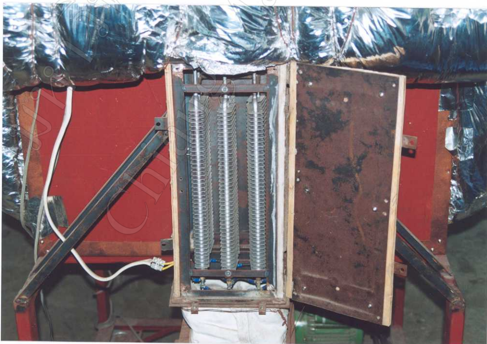
รูปผนวกที่ 8 กล่องบรรจุหลอดความร้อนแบบครีขนาด 600 วัตต์ 6 ตัว
