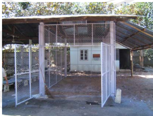
ภาพที่ 3 แสดงอาคารผลิตไบโอดีเซลหลังการดำเนินการปรับปรุง
