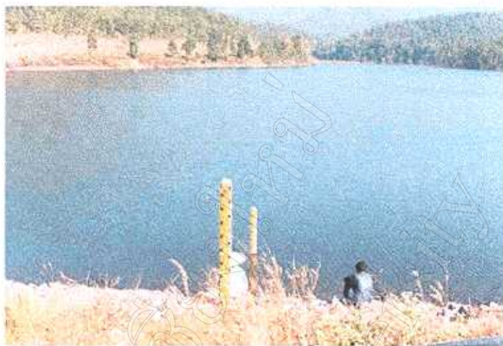
สภาพอ่างเก็บน้ำห้วยแม่ใจ
