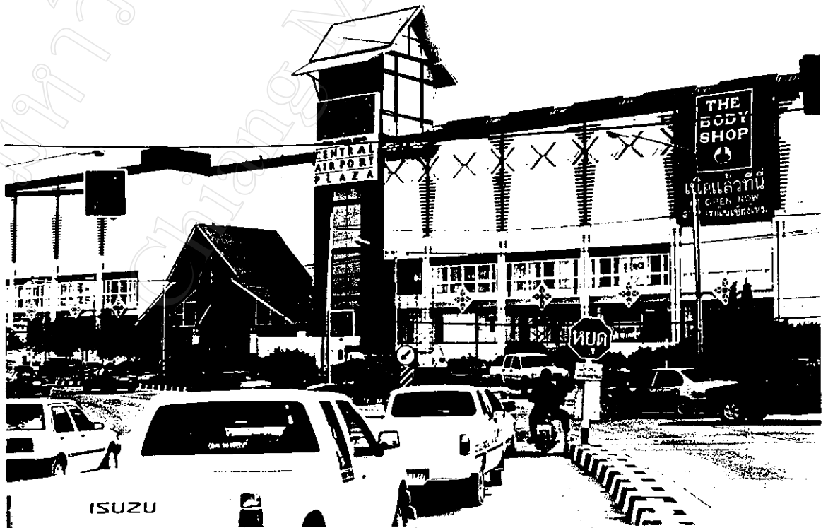
ภาพที่ 27 อาคารห้างสรรพสินค้าริมถนนมหิดลสร้างในรูปทรงกล่องสี่เหลี่ยม
