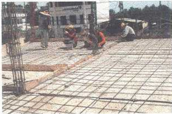
ภาพที่ 9 การผูกเหล็กเพื่อเททับหน้า
