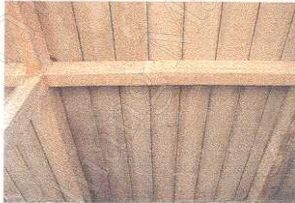
ภาพที่ 12 พื้นคอนกรีตหลังจากถอดไม้ค้ำยัน
