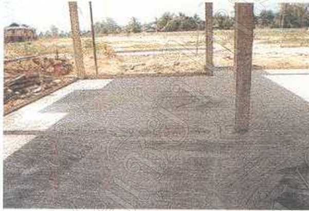
ภาพที่ 11 การบ่มคอนกรีตด้วยน้ำ
