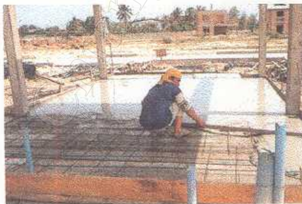
ภาพที่ 10 การเทคอนกรีตทับหน้า (TOPPING)
