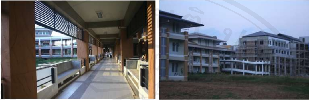
ภาพ 2.7 ทางเดินหลักในอาคาร (Arcade) เชื่อมอาคารต่อเนื่องทุกชั้น (มหาวิทยาลัยพะเยา)
