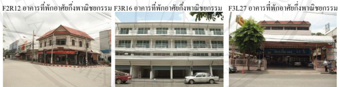
F2R12 อาคารที่พักอาศัยกึ่งพาณิชย์กรรม บ้านพักอาศัยและมีความสูง 2 ชั้น F3R16 อาคารที่พักอาศัยกึ่งพาณิชย์กรรม ที่มีหลังคาจั่ว และความสูง 3 ชั้นครึ่ง F3L27 อาคารที่พักอาศัยกึ่งพาณิชย์กรรม ที่มีหน้ามุขจั่ว และความสูง 3 ชั้นครึ่ง
