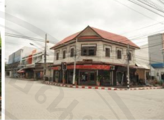
F2R12 อาคารพักอาศัยกึ่งพาณิชย์กรรม
