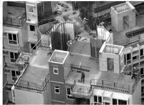
ภาพที่ 2.13 แสดงระบบชิ้นส่วนสำเร็จรูประบบกล่อง โครงการ ONE CENTRAL, MACAU 2006 ที่มา: ปรับปรุงจาก สามชัย รมทอง และคณะ (2547)
