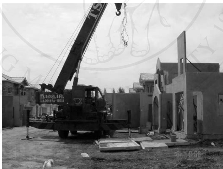
ภาพที่ 2.15 แสดงภาพการติดตั้งและประกอบชิ้นส่วนสำเร็จรูป
