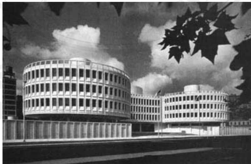
ภาพที่ 2.6 Philadelphia Police Administration Building ที่มา Precast/Prestressed Concrete Institute. (2004)
