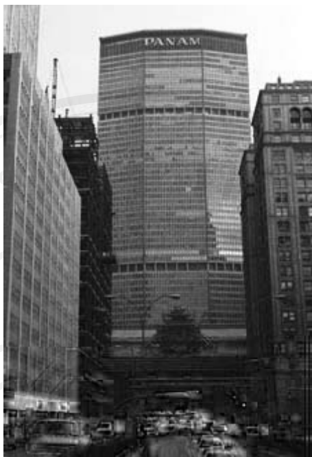
ภาพที่ 2.7 อาคารสำนักงาน Pan-Am ที่มา Precast/Prestressed Concrete Institute. (2004)
