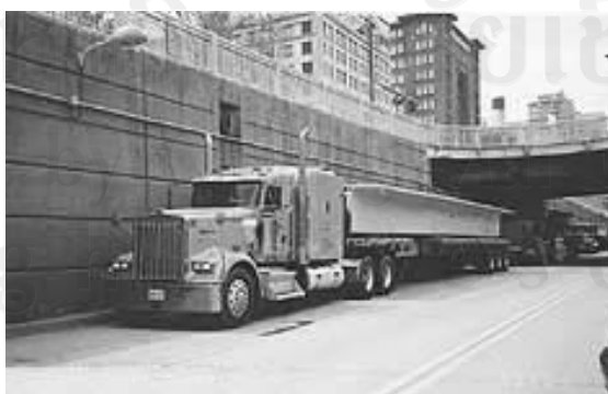
ภาพที่ 2.20 แสดงภาพการขนส่งชิ้นส่วนสำเร็จรูป
