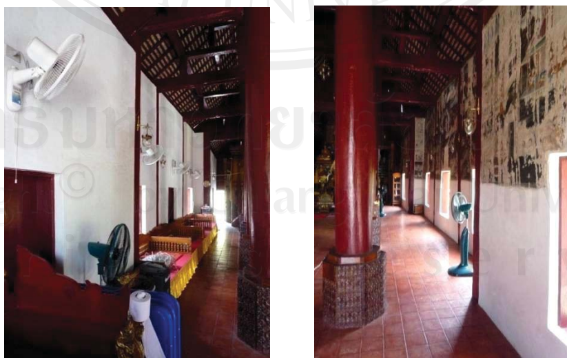
ภาพ 4-102, 103 วิหารวัดเสนาหิน ติดตั้งพัดลมแขวนผนังด้านที่ไม่มีจิตรกรรม ด้านที่มีจิตรกรรมใช้พัดลมตั้งพื้น (ที่มา : การลงพื้นที่สำรวจ 5-4-53)
