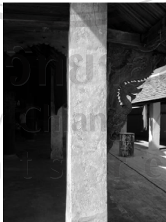
ภาพที่ 4.24 ภาพเสาที่เปลี่ยนจากเสาไม้เป็นเสาคอนกรีตของวิหารน้ำแต้ม
