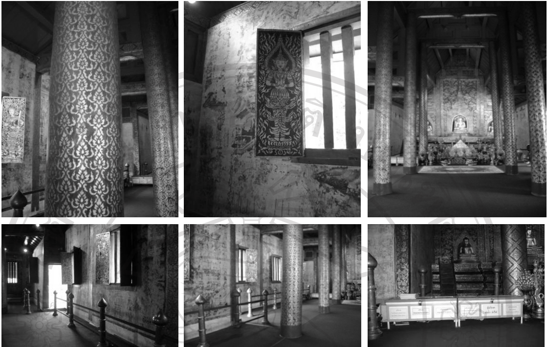
ภาพที่ 4.37 ภาพรวมแสดงสภาพภายในของวิหารลายคำแสดงถึงภาพรวมถึงลายคำและภาพจิตรกรรมฝาผนัง มีอายุที่นานก็จะการหลุคร่อน แม้จะมีการบูรณะหลายครั้งแล้วก็ตาม แต่สภาพอากาศ ณ ปัจจุบัน มีสภาพมลภาวะที่แตกต่างไปจากอดีตมาก ทำให้มีการติดตั้งราว เพื่อป้องกัน ประชาชนสัมผัสและจับดู ซึ่งอาจจะก่อให้เกิดความเสียหายต่อ จิตรกรรมและลายคำ (ภาพถ่ายโดยผู้วิจัย วันที่ 15 ธันวาคม พ.ศ.2551)
