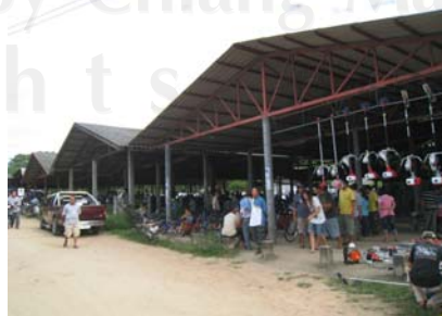
ภาพ 4-15 พื้นที่อาคารถาวร ภายในภาคทุ่งฟ้าบด
