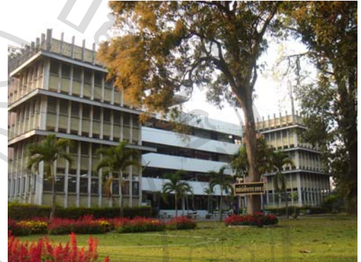
ภาพที่ 4.1.2 แสดงลักษณะอาคารหอพักชาย 2
