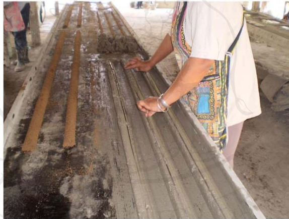
ภาพ 3.12 การวางลวดบนบัวซีเมนต์มอด้า
