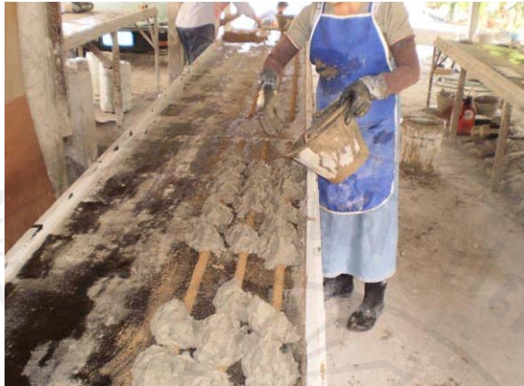
ภาพ 3.4 การหยอดคอนกรีตบนฐานทราย
