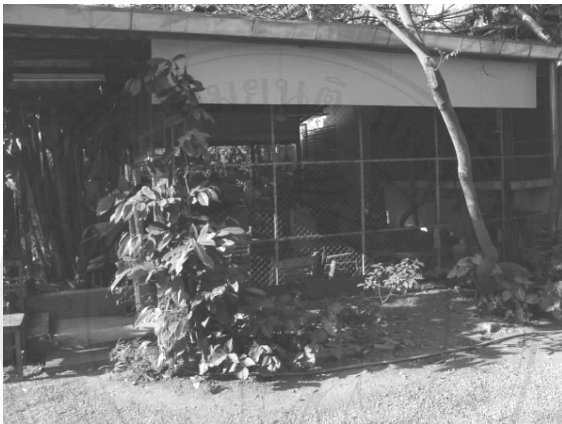
ภาพ 4.23 แสดงการจัดการพื้นที่อย่างถาวร โดยการสร้างสิ่งปลูกสร้างเข้าไปทับ ทำให้ตำแหน่งและขอบเขตของกายภาพชัดเจน
