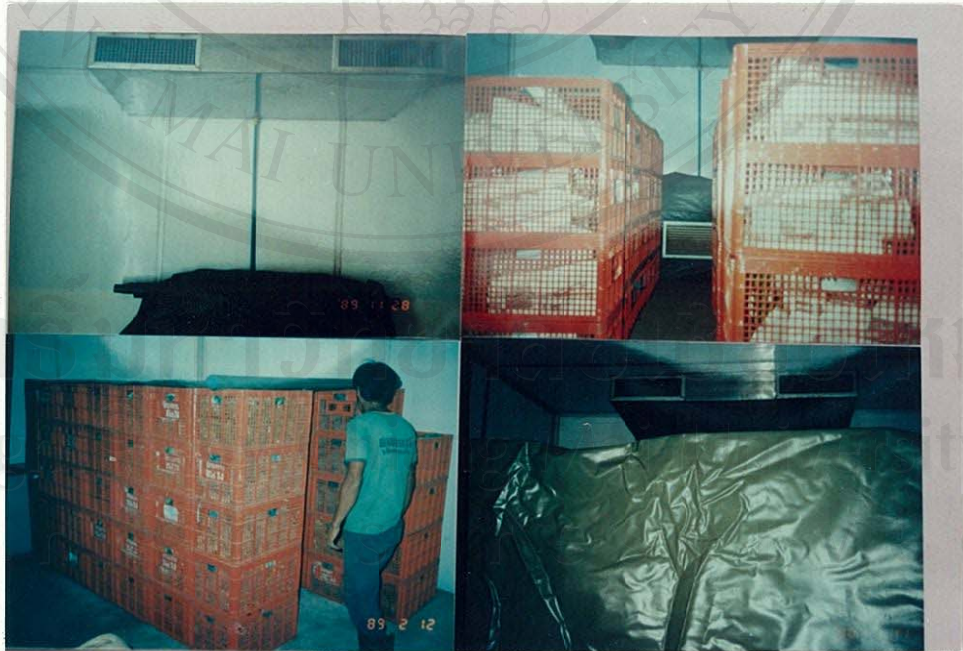
ภาพที่ 1 ห้องลดอุณหภูมิเฉียบพลันชนิดผ่านอากาศเย็น
