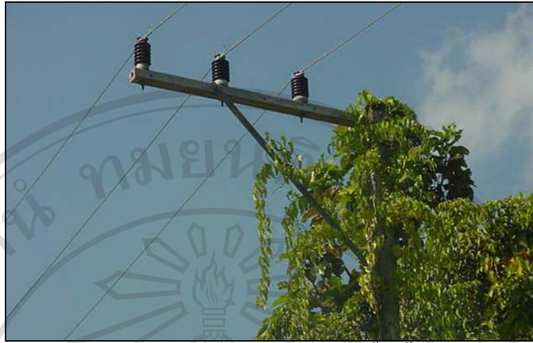
รูป 2.2 ลักษณะระบบจำหน่ายที่มีกิ่งไม้เลื้อยขึ้นตามเสา ซึ่งมีโอกาสเกิดการลัดวงจรขึ้นได้เมื่อมีพายุฝนลมแรง
