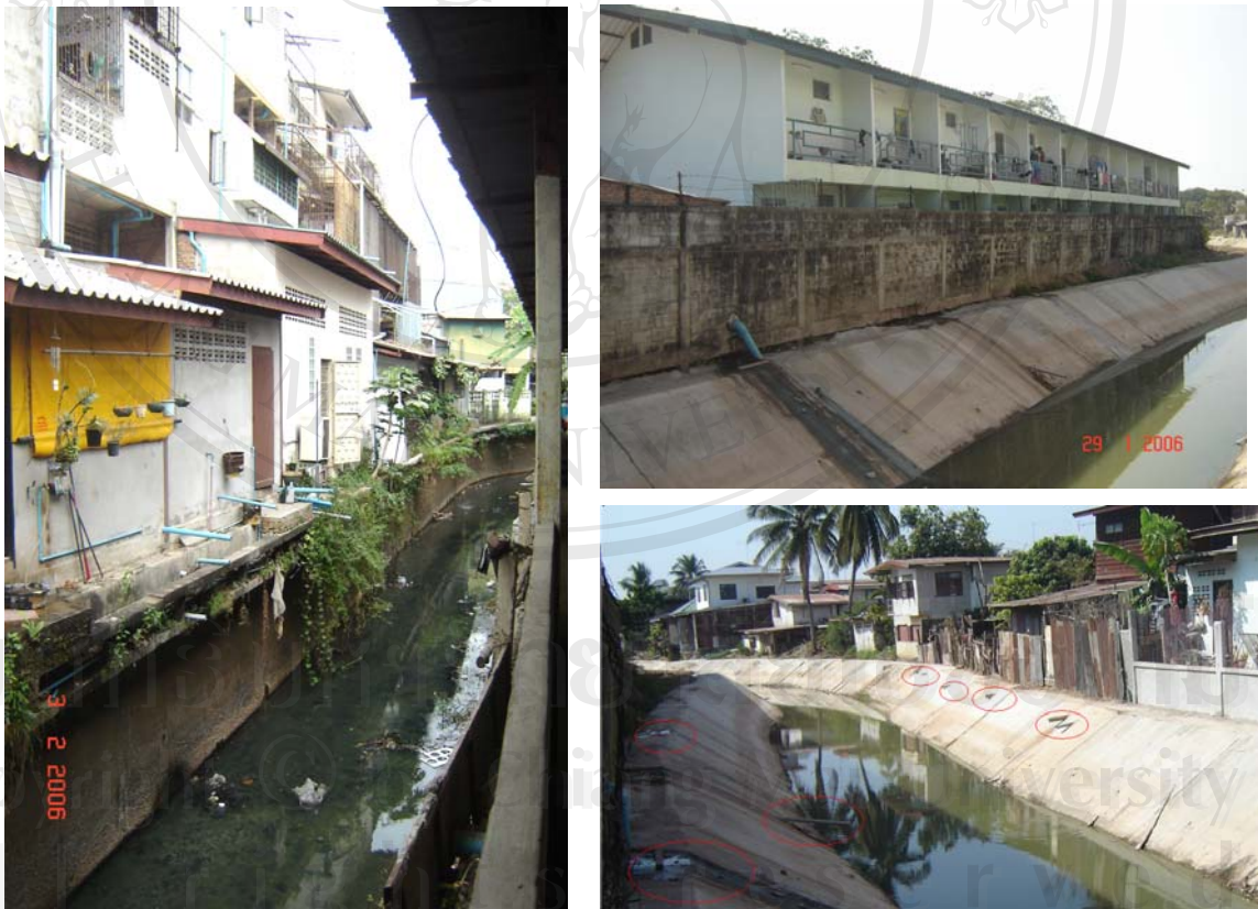
รูปที่ 13 การต่อท่อระบายน้ำทิ้งจากตึกแถว หอพัก บ้านพัก ลงสู่ลำห้วยสาธารณะโดยตรง
