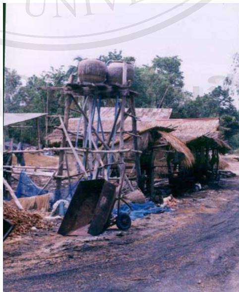
ภาพที่ 10 ถังพักตะกอน
