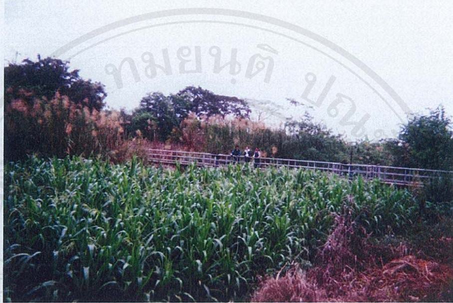
ภาพ 1 โครงสร้างตัวฝายของเหมืองฝายป่ายาง
