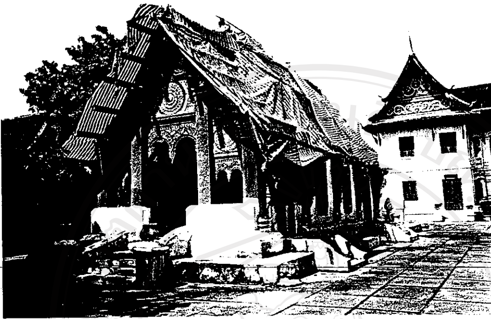
ภาพที่ 4.11 วิหารวัดคีรีรถการซ่อมแซมจากห้องการมรดกโลก
