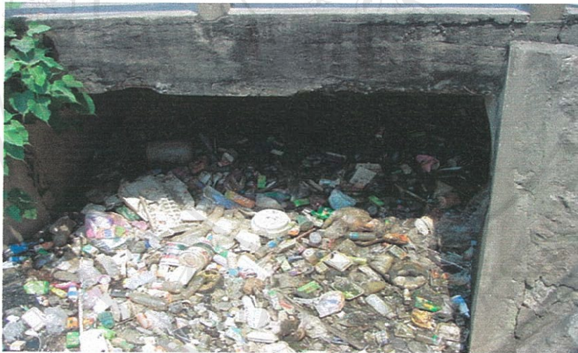
ภาพที่ 1 แสดงสภาพร่องระบายน้ำที่มีแต่ขยะปกคลุมกีดขวางทางน้ำไหล
