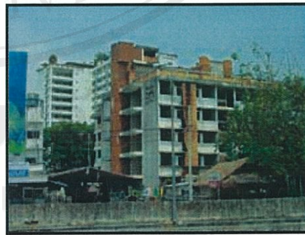
ภาพที่ 8 อาคารร้างในชุมชนช่างเคียน
