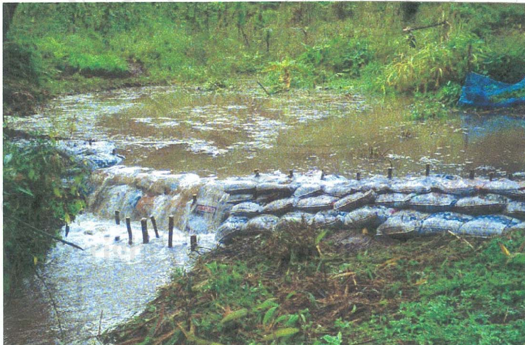
ภาพที่ 9 ฝ่ายชั่วคราว (Check Dam) ก่อสร้างโดยกรมอุทยานแห่งชาติ สัตว์ป่า และพันธุ์พืช
