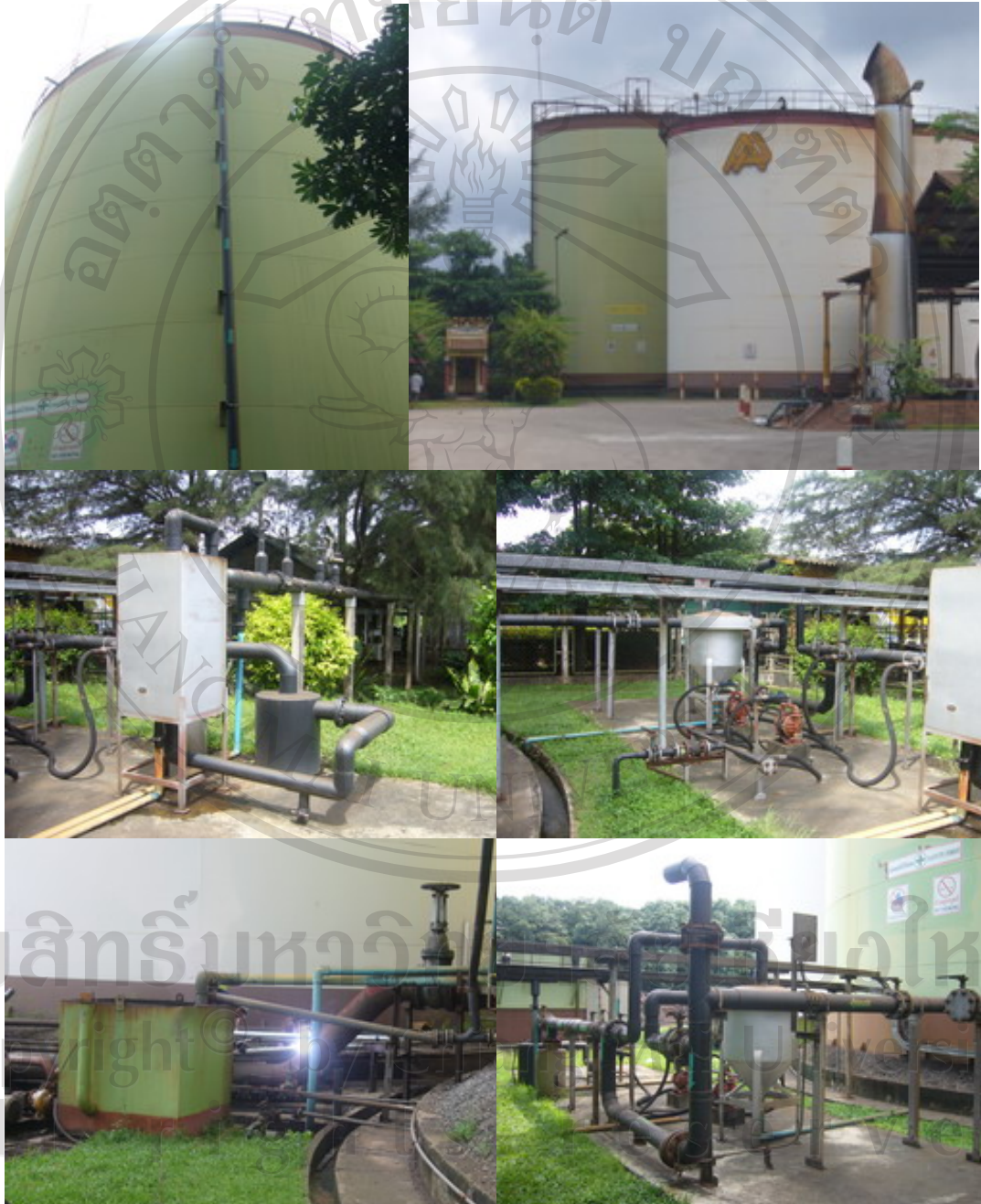
รูปที่ 4.4 แสดงถังผลิตแบบ CSTR และระบบสูบน้ำเข้า-ออกจากถังผลิต
