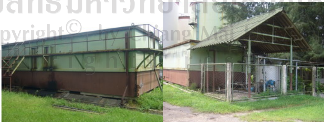
รูปที่ 4.3 แสดงบ่อกักน้ำเสีย
