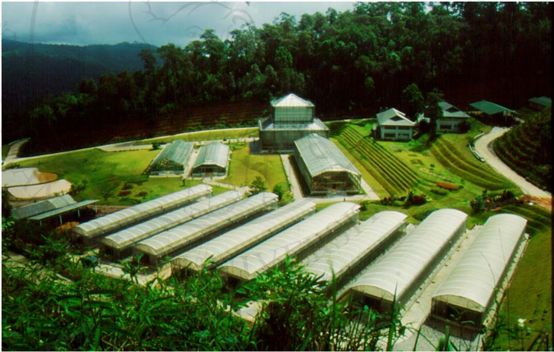
ภาพ 4.4 กลุ่มอาคารเรือนกระจก
