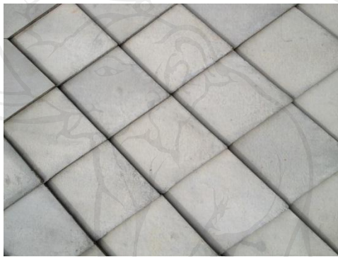
รูป 5 กระเบื้องปูนซีเมนต์แบบหางว่าว(ปลายแหลม)
