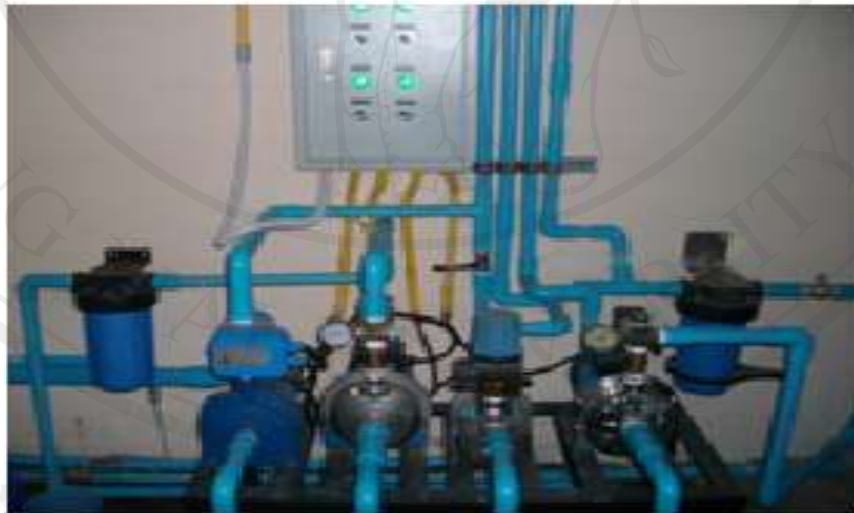
ภาพที่ 6 แสดงปั้มน้ำสำหรับส่งน้ำไปบรรจุ
