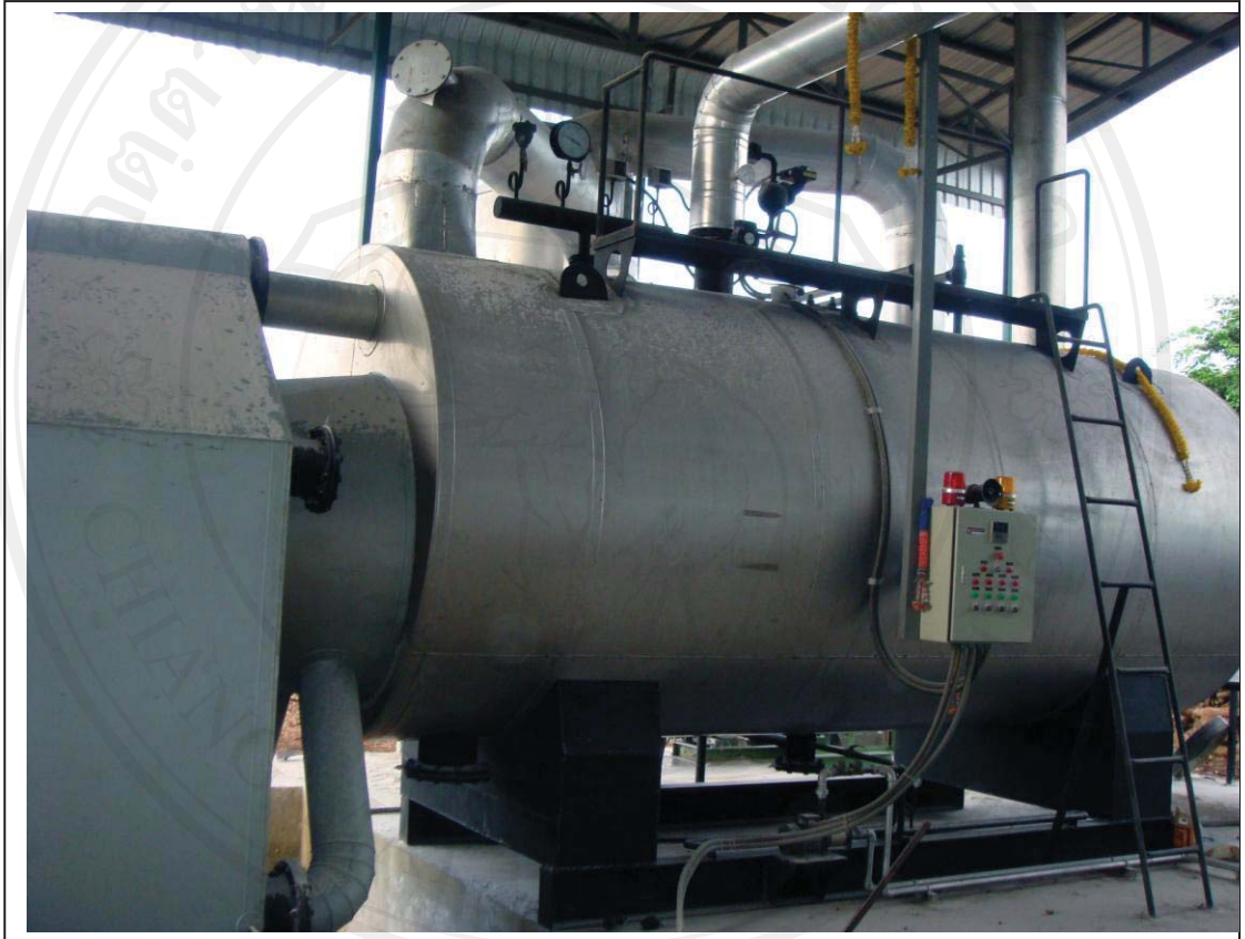
ภาพภาคผนวกที่ 1 หม้อน้ำร้อนที่ใช้เป็นแหล่งพลังงานความร้อนในการอบลำไย
