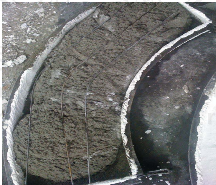
ภาพที่ 41 การวางเหล็กเส้น
