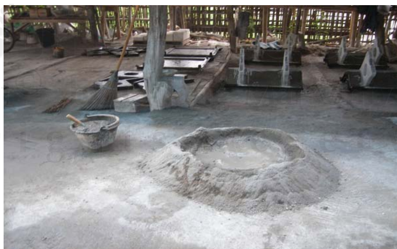
ภาพที่ 27 การผสมปูนดำทรายละเอียดและน้ำ
