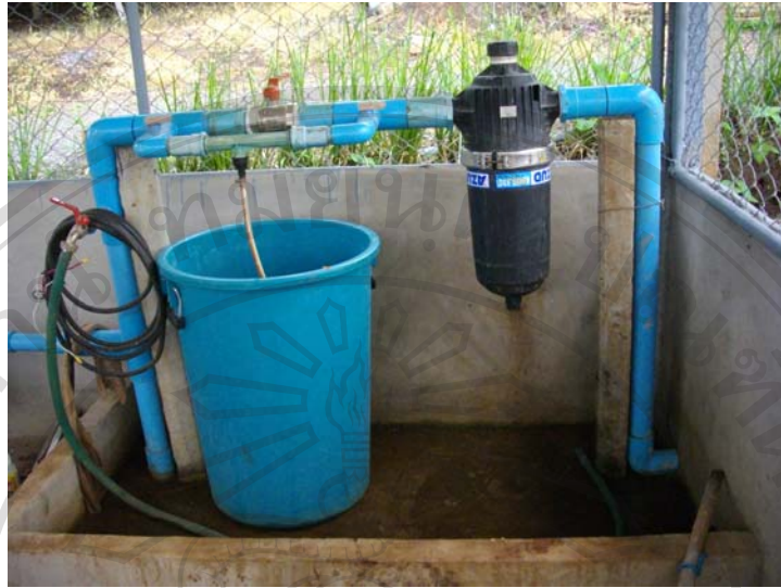
ภาพที่ 2.11 ถังบรรจุ 200 ลิตร เพื่อผสมปุ๋ยและเครื่องกรองน้ำเพื่อให้ น้ำที่สูบขึ้นมา มีความสะอาด
