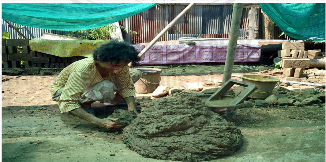
ภาพที่ 3-6 กองดินเป็นระยะกะเอาว่าดินกองหนึ่งพอเหมาะกับการอัดแห้งดินเต็มพื้นที่ด้านข้าง
