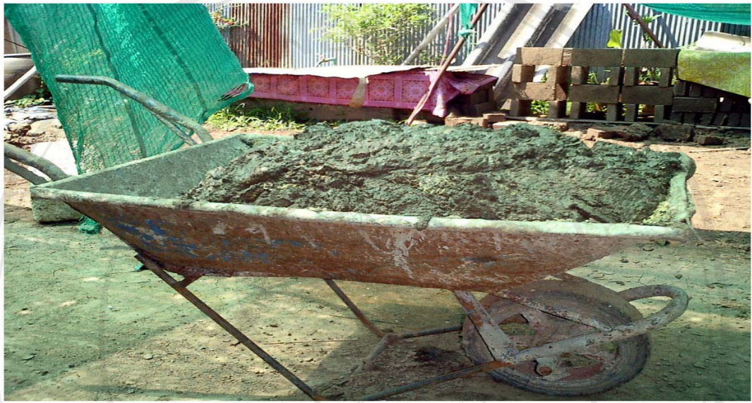
ภาพที่ 3-5 ดินที่ผสมจนได้ที่ขึ้นรถเข็นเพื่อทำการอัดพิมพ์ต่อไป
