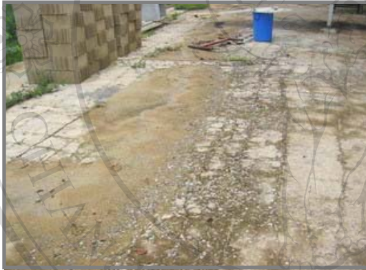
ภาพที่ 4.7 สภาพพื้นบริเวณรอบอาคารผลิตไม่เรียบ
