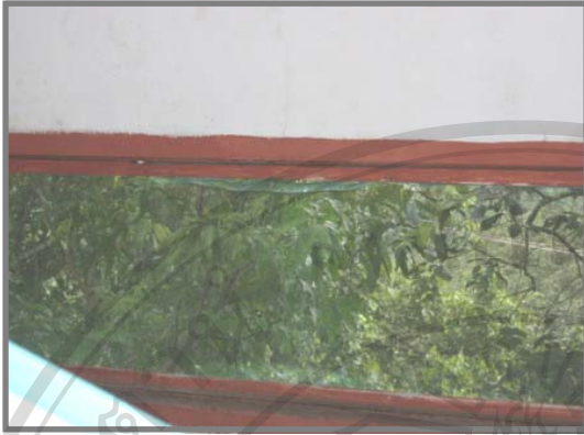
ภาพที่ 4.23 มุงลวดหน้าต่างห้องผลิต 1 ชำรุด
