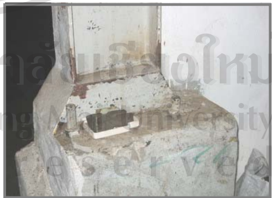
ภาพที่ 4.16 เสาปูนไม่เรียบและเป็นมุมฉาก
