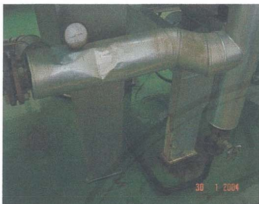
ภาพที่ 4.8 เครื่องมืออุปกรณ์มีผิวไม่เรียบ สม่ำเสมอ
