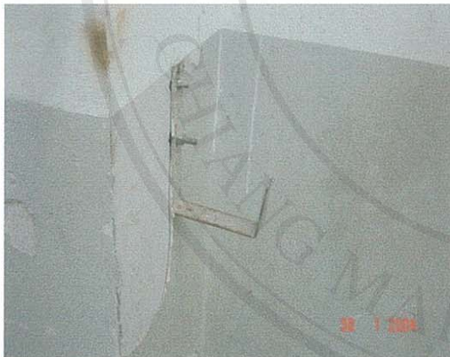
ภาพที่ 4.6 พื้นผิวผนัง ไม่ฉาบด้วยกระเบื้องที่ทนน้ำทำให้สีผนังหลุดลอก
