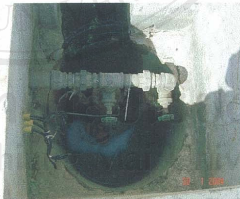
ภาพที่ 4.15 ท่อระบายมีขนาดเล็ก การระบายน้ำ จึงไม่มีประสิทธิภาพ
