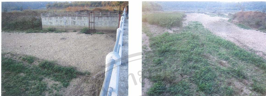
ภาพที่ 4.12 – 4.13 ฝ่ายมะขามป้อม ที่ชำรุดเนื่องจากมีดินทรายกองไว้หน้าฝาย จากสถานการณ์น้ำท่วม
