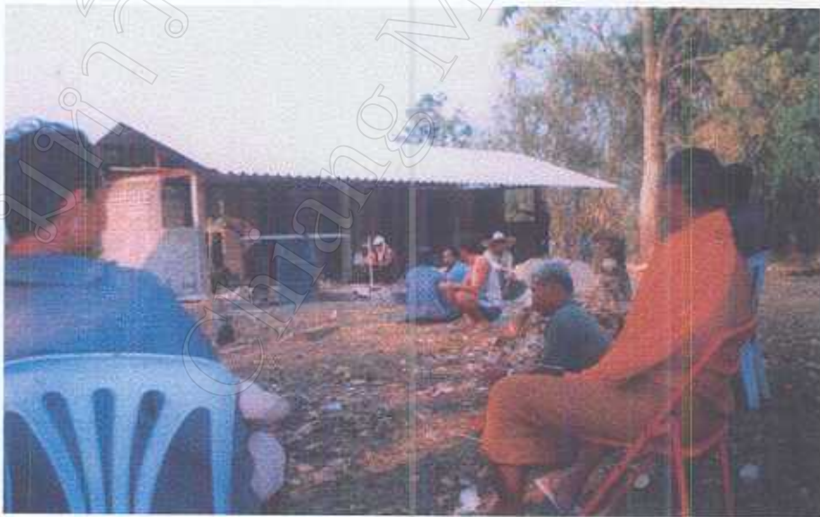
ชาวบ้านป่าเลาร่วมแรงร่วมใจสร้างห้องน้ำของวัด
