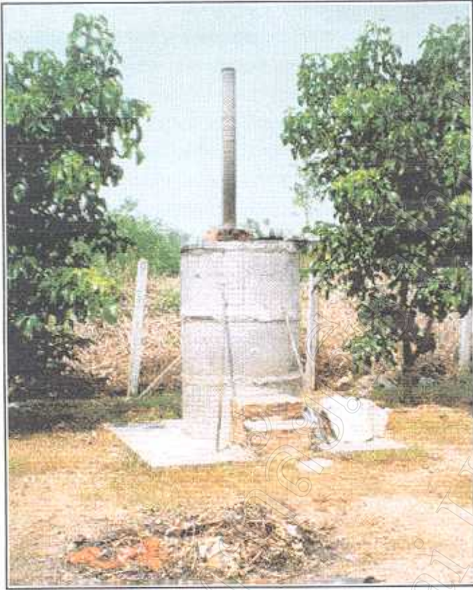
ภาพแสดง ลักษณะเตาเผามูลฝอย ของสถานีนอนามัย
