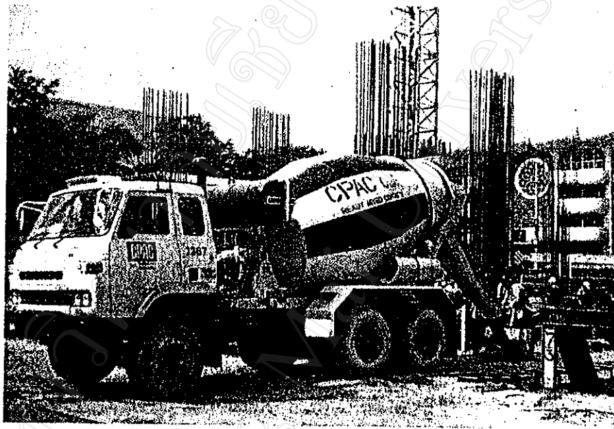
รูปที่ 9 แสดงรถขนส่งคอนกรีต
