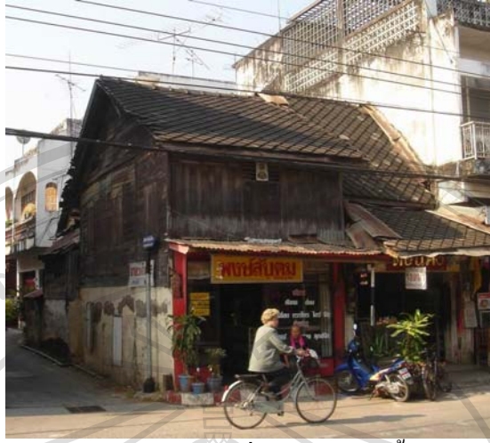
ภาพ 4.10 เรือนไม้ร้านค้าทรงจั่วมุงด้วยกระเบื้องซีเมนต์ B21
