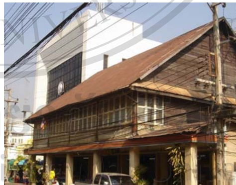
ภาพ 4.7 Colonnade แบบใต้ถุน B13
