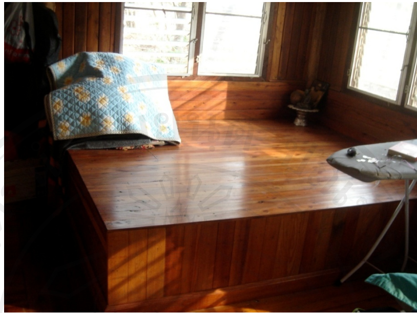
ภาพที่ 3.9 เติงภายในตัวที่ก่อสร้างจากไม้ยูคาลิปตัส
