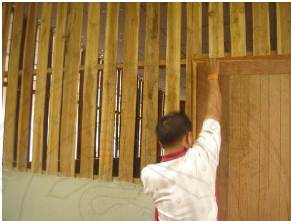
ภาพที่ 3.17 การใช้ไม้สักอายุ 6 ปี ในการทำฝาห้องครัว อาคารโรงครัว
