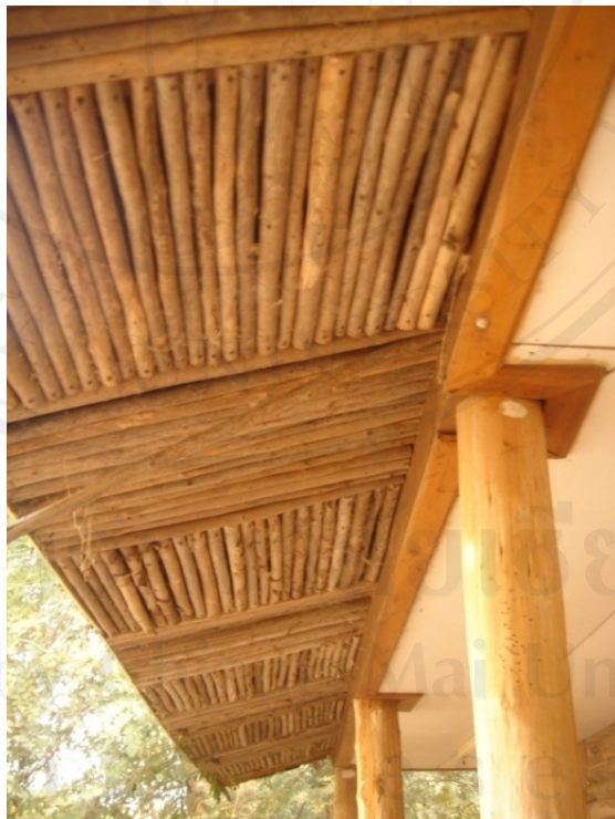
ภาพที่ 3.10 การใช้กิ่งไม้ที่เหลือในงานก่อสร้าง
