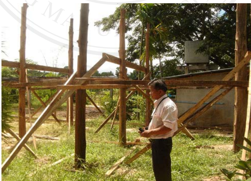
ภาพที่ 3.13 การสร้างบ้านพักอาศัยจากไม้ที่ปลูกเอง
