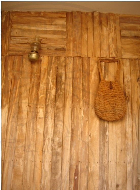
ภาพที่ 3.11 การใช้ปีกไม้ที่เหลือในงานก่อสร้าง
