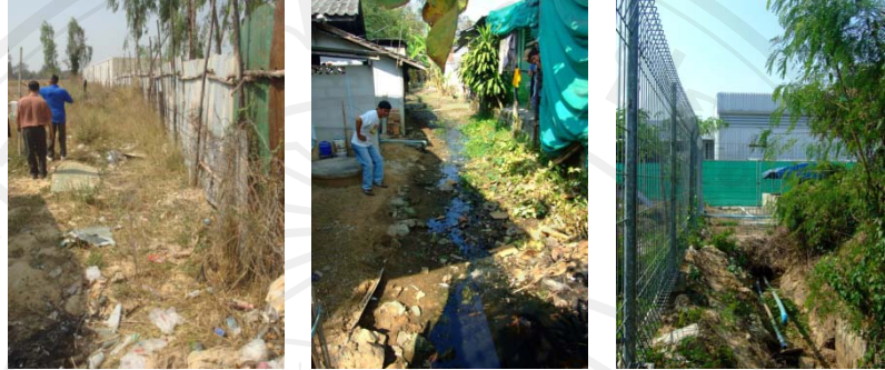
ภาพที่ 53-55 การถมลำเหมืองเสียน้ำบ้านสันหลวง การถูกล้ำพื้นที่สองฝั่งของลำเหมืองของชุมชน และการวางสิ่งกีดขวางในลำเหมืองพร้อมยึดลำเหมืองเป็นส่วนหนึ่งของโรงงาน
