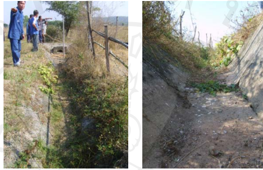
ภาพที่ 58-59 ตัวอย่างการปรับปรุงลำเหมืองไม่ได้ระดับการส่งน้ำ
