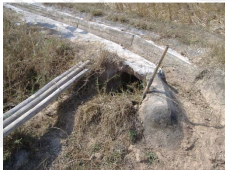
ภาพที่ 46-47 ตัวอย่างการชำรุดของลำเหมือง
