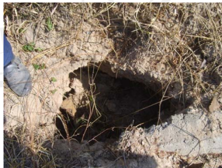
ภาพที่ 46-47 ตัวอย่างการชำรุดของลำเหมือง
