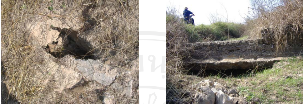
ภาพที่ 60-61 ตัวอย่างเขียงแบ่งน้ำที่ชำรุด และเขียงแบ่งน้ำที่ชำรุดจากการวางกับดัก
