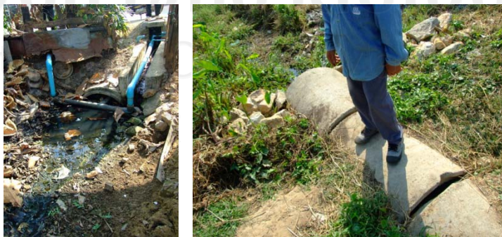
ภาพที่ 50-51 การวางท่อที่ไม่ได้ระดับ และขนาดภายในชุมชน
