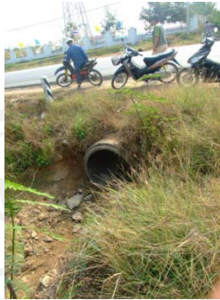
ภาพที่ 52 การวางท่อที่ไม่ได้ขนาดของหน่วยงานที่รับผิดชอบบริเวณข้างอบจ. ลำพูน
