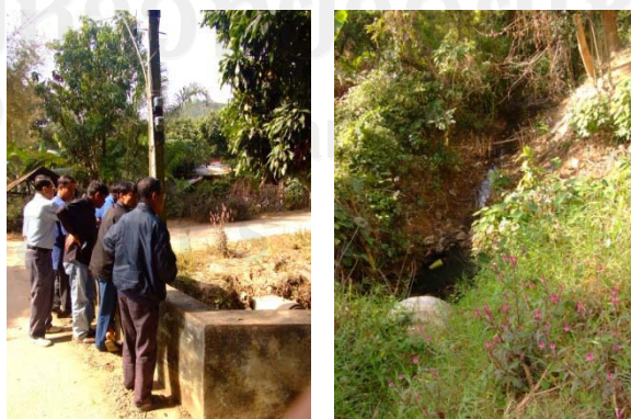
ภาพที่ 78-79 ติดตามการวางท่อลอดถนนบ้านข้าวแครงเพื่อนำน้ำมาลงบริเวณหน้าฝายมหาโชค
