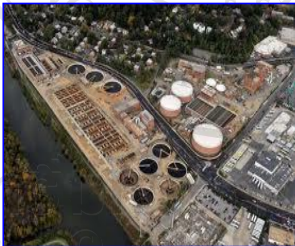
ภาพ 12 สถานีบำบัดน้ำ เมืองอาร์ลิงตัน รัฐเวอร์จิเนีย ประเทศสหรัฐอเมริกา
