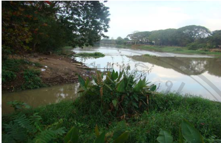
ภาพ 5 ฝ่ายท่าศาลาหลังการซ่อมเมื่อปี 2534
