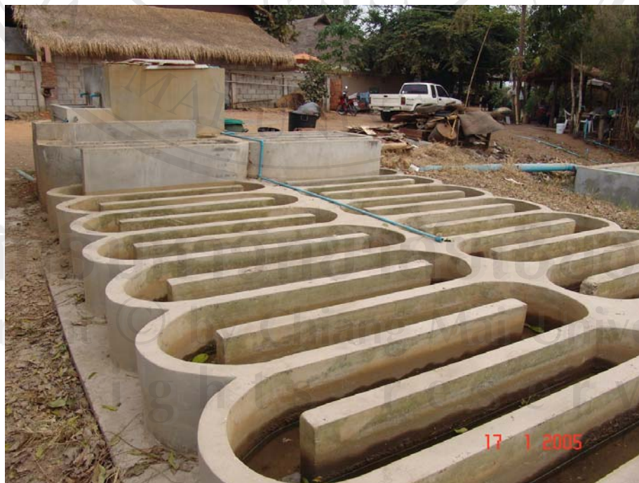
ภาพที่ 4.10 แสดงระบบบำบัดน้ำเสียของรีสอร์ทที่มีการบำบัดน้ำเสียในอำเภอไทรโยค
